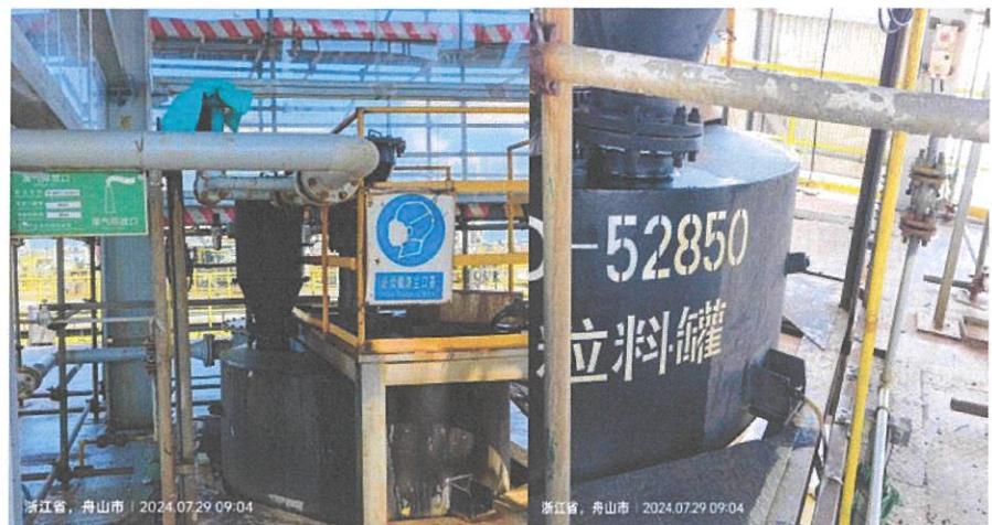
图 4-7 催化剂料仓废气处理设施现场照片
