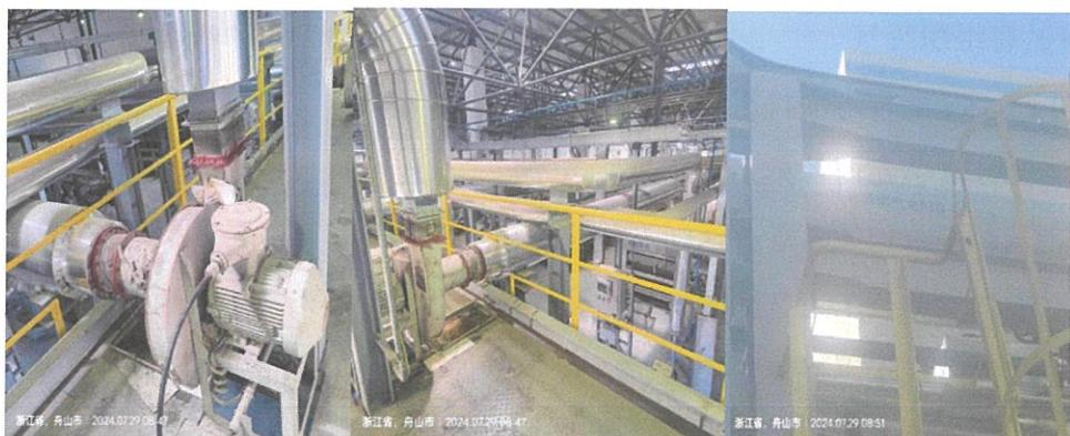
1#造粒及包装厂房间戊二烯树脂包装废气，连续排放，主要污染物为颗粒物，送布袋除尘器除尘后排入大气。
