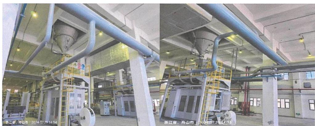
图 4-8 包装废气处理设施现场照片
