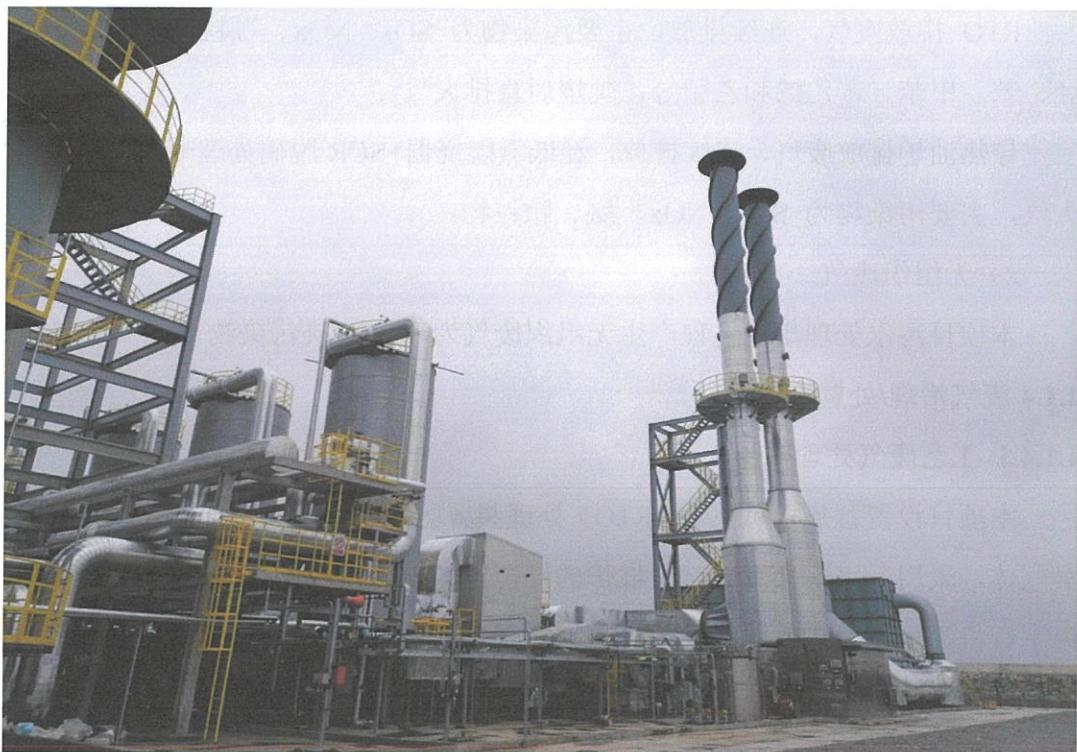
图 4-5 RTO 废气处理设施现场照片
